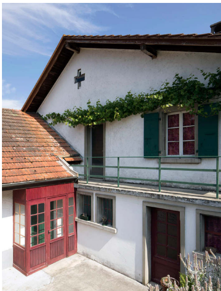
Terrasse et dépendance avant transformation
