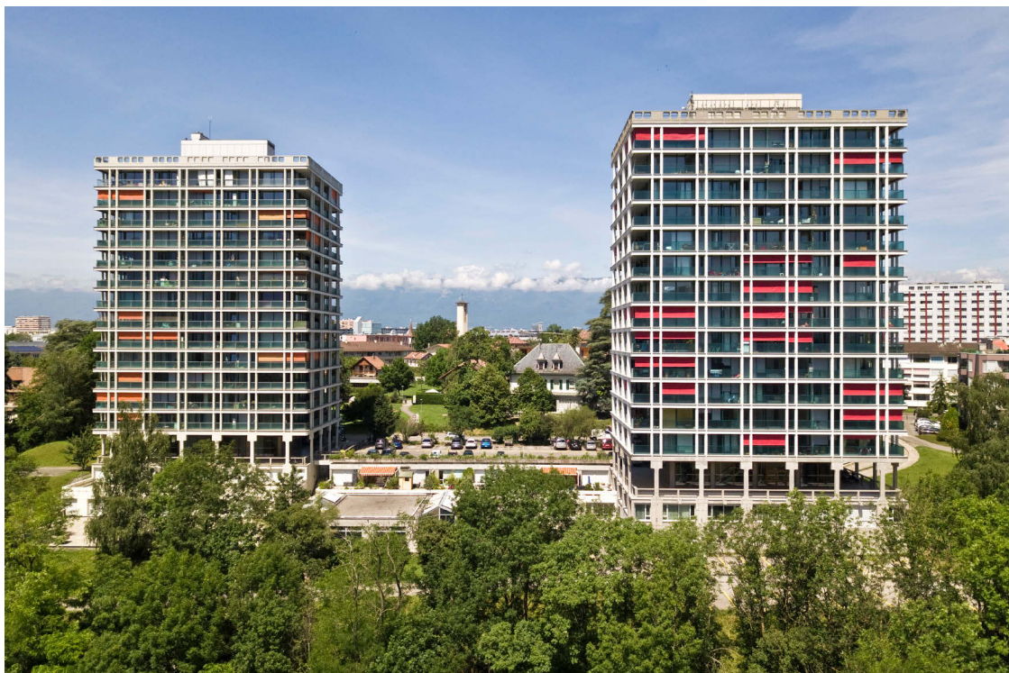
Photo aérienne: Omarini Micello Architectes SA
