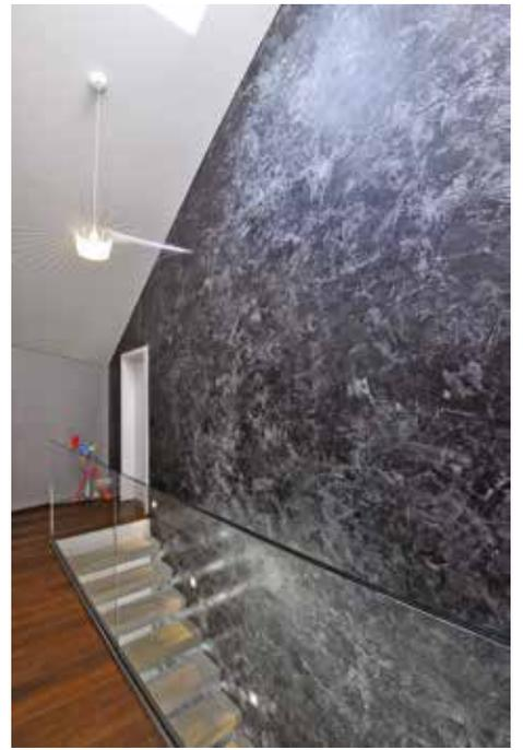
l'espace, délimité d'une part par une paroi de verre et d'autre part par le mur porteur, dans lequel sont ancrées les marches.
