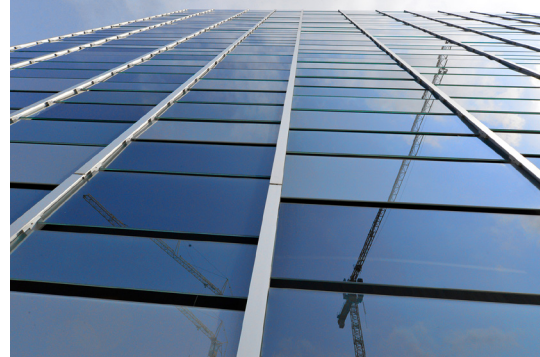
Façade vitrée composée de 2'900 panneaux de verre
