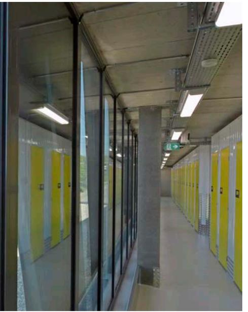
Le solde est réalisé en panneaux sandwichs (1'700 m<sup>2</sup>) et poteaux-traverses, mesurant chacun 6 mètres de hauteur sans support intermédiaire. Le bâtiment intègre également des vitrages SageGlass, dont la teinte varie
