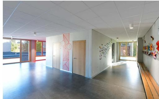
Dans les circulations, les matériaux neutres et naturels sont privilégiés. On retrouve le béton brut pour les murs, une chape poncée teintée pour les sols et des portes en chêne pour amener ce côté chaleureux. Les murs béton sont traités avec une lasure pour les éclairer et les protéger.
